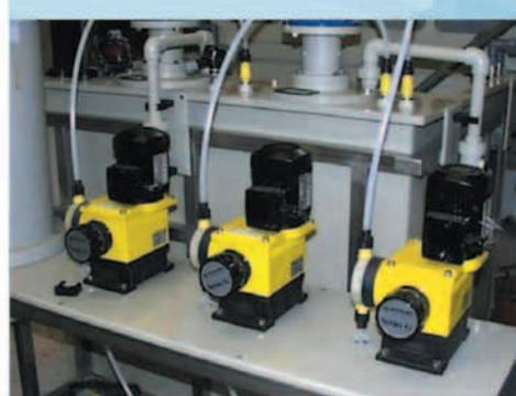
Dávkování koagulantu, flokulantu a hydroxidu sodného.
